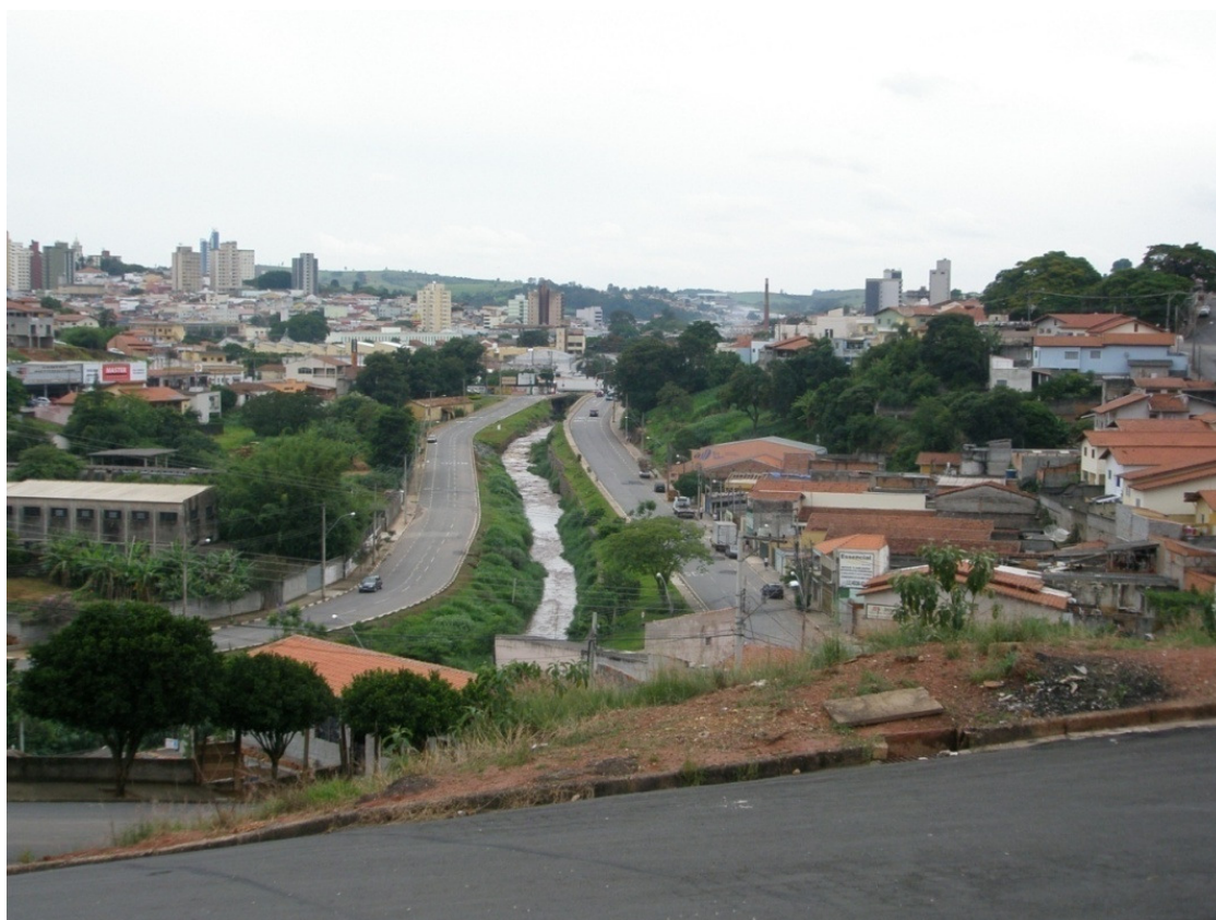
Figura 53: Vista do ribeirão Jacaré e das Avenidas Alberto Palladino (Esq.) e José Edgar Sanfins (Dir.) (Foto: Gustavo C. de A. Franco/2008)
