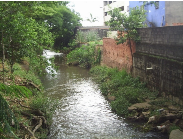
Figura 20: Construções à beira do ribeirão Jacaré (Foto: Gustavo C. de A. Franco/2008)
