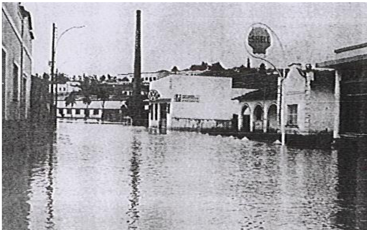
Figura 5: Avenida Marechal Deodoro, que sempre foi um dos pontos mais atingidos pelas inundações do ribeirão Jacaré (Foto: 1970 – Relatório da Administração Municipal 1973-1976)
