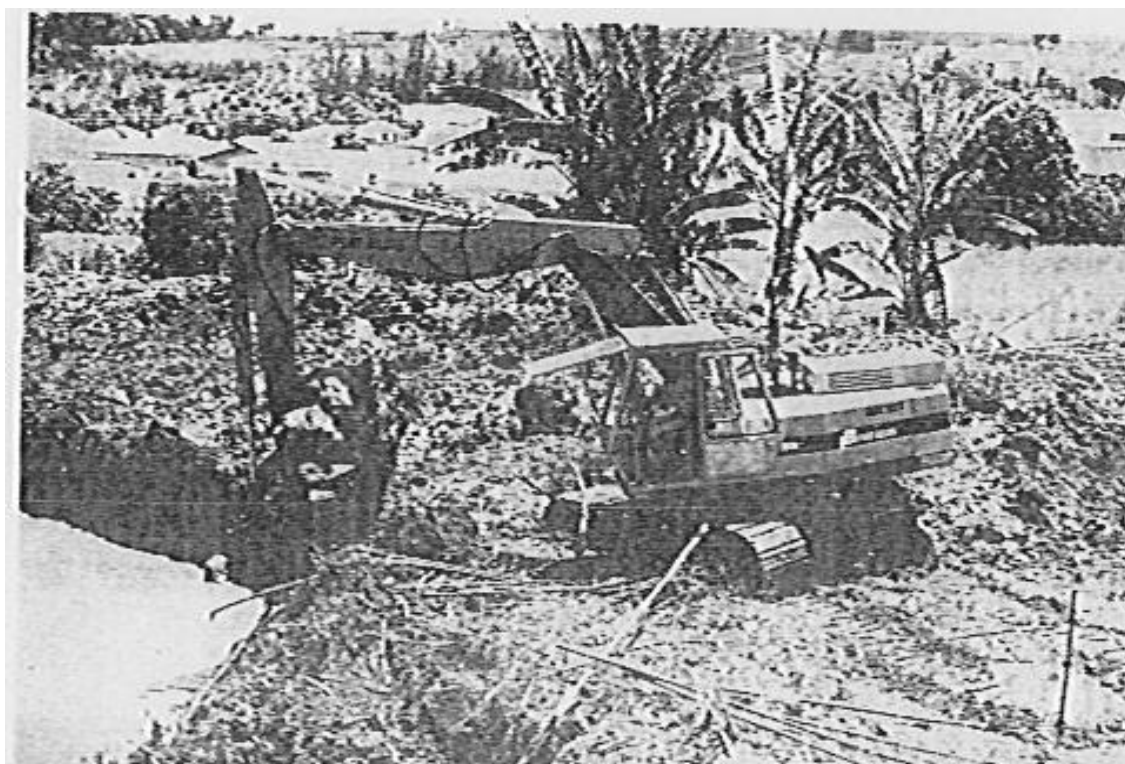
Figura 11: Uma das máquinas do grupo-tarefa do DAEE que auxiliaram nas obras contra as cheias (Fonte: Relatório da Administração Municipal 1973-1976)
