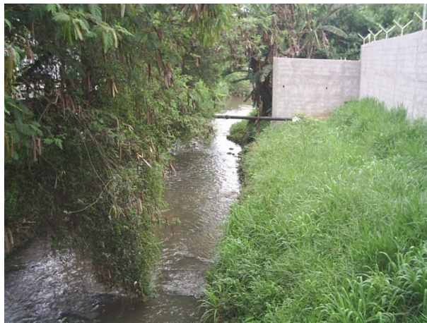
Figura 38: Muro de prédio da prefeitura até o limite da margem do ribeirão Jacaré (Foto: Gustavo C. de A. Franco/2008)
