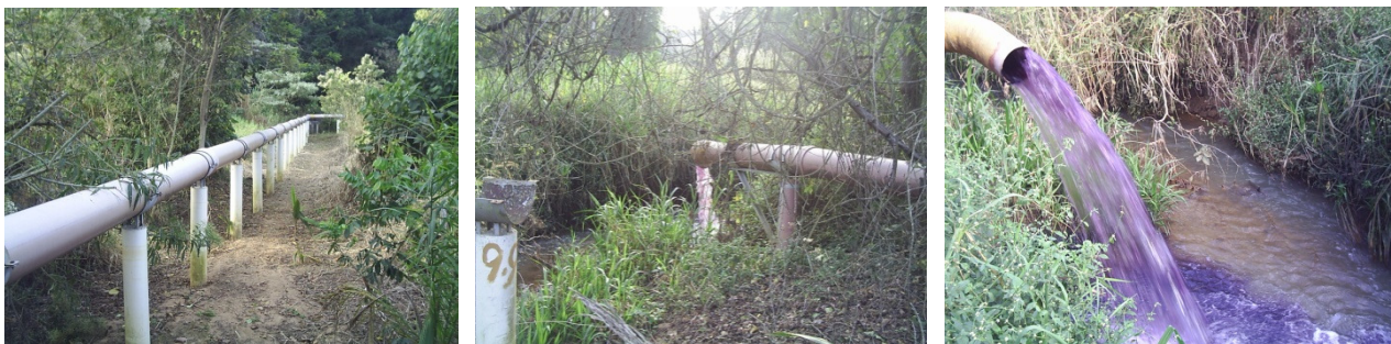
Figura 19: Seqüência que mostra o esgoto industrial percorrer vários metros dentro de encanamentos até desaguar no ribeirão Jacaré (Foto: Gustavo C. de A. Franco/2008)
