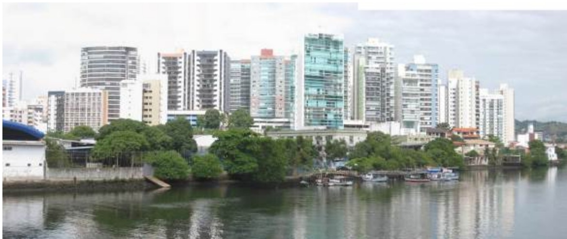
Figura 28: Canal da Passagem margem insular. Detalhe para os acessos individuais e elevado padrão construtivo.
