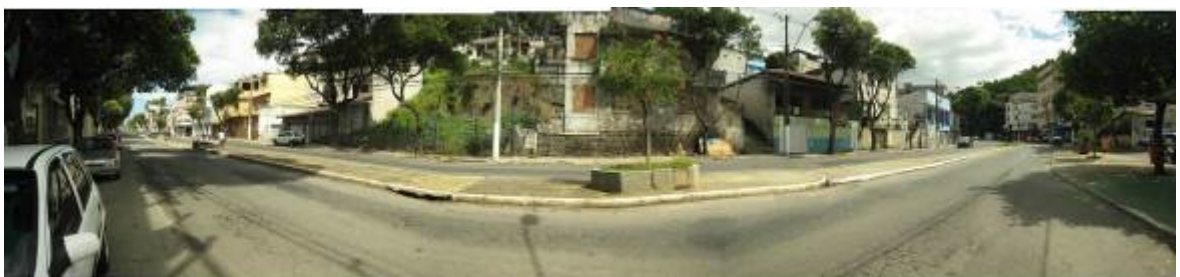
Figura 1: Canal Tamponado na Avenida Paulino Müller.
