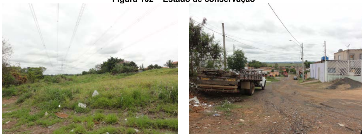
Figura 102 – Estado de conservação
