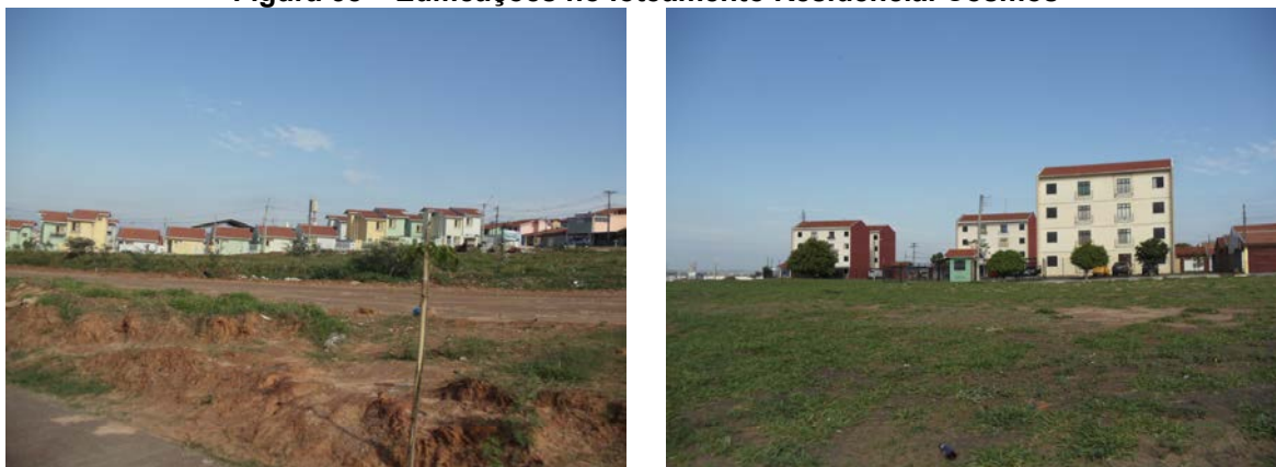
Figura 58 – Edificações no loteamento Residencial Cosmos
