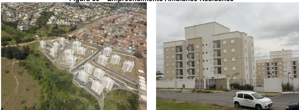
Figura 89 – Empreendimento Ambiance Residence
