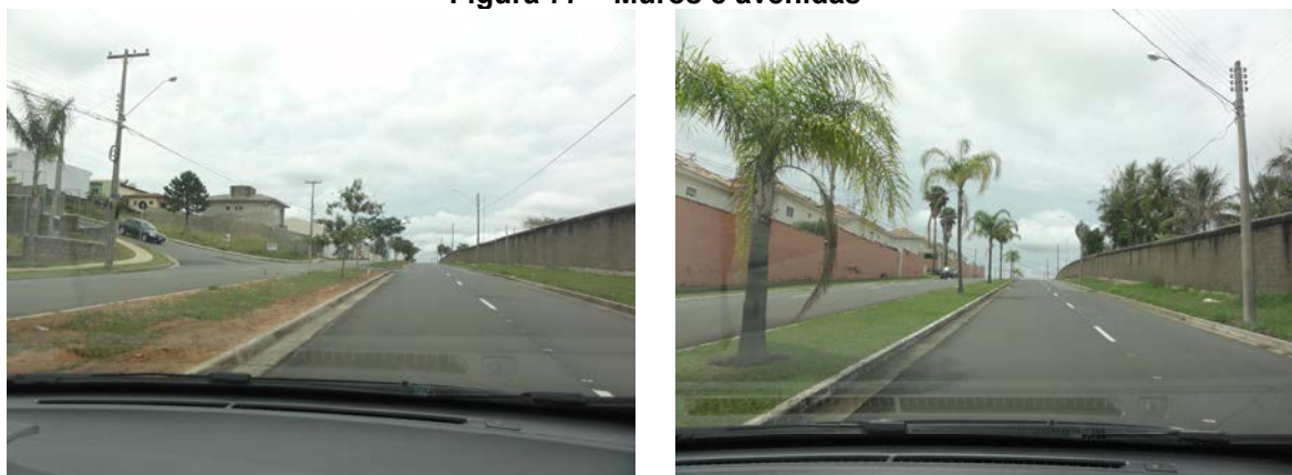
Figura 77 – Muros e avenidas
