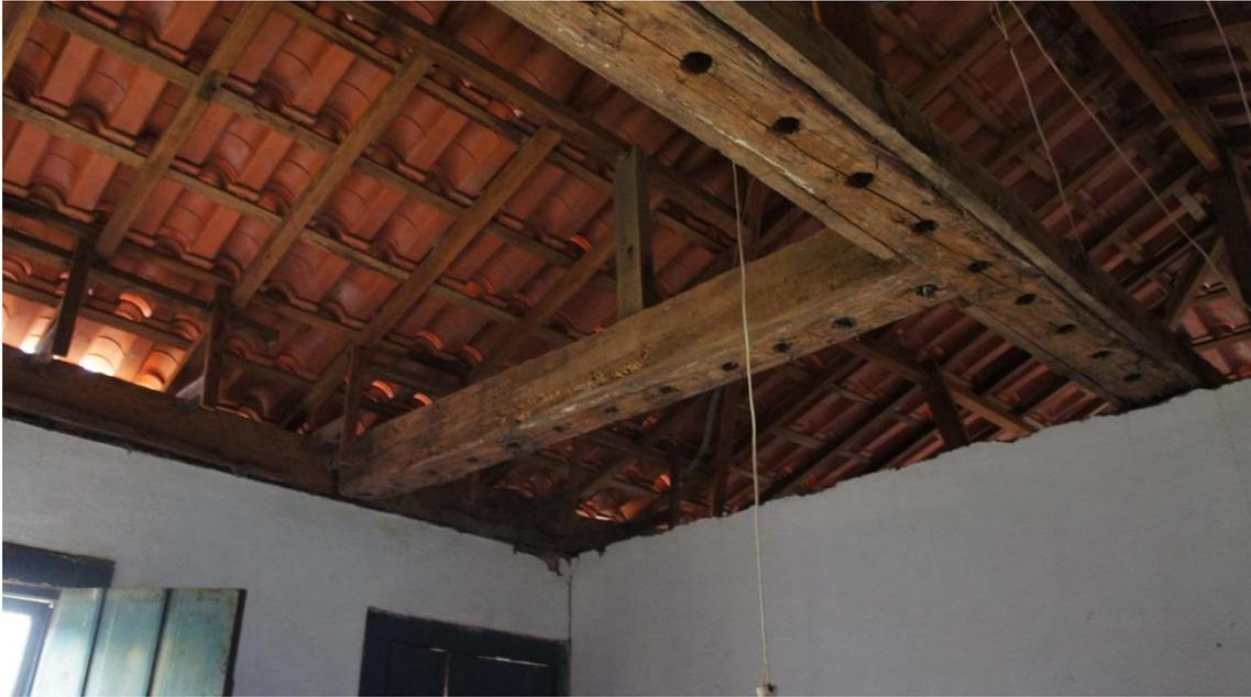
Figura 33: Foto do interior do casarão da Fazenda Barreiro, revelando a estrutura de madeira onde se fixavam as espigas nos frechais.
