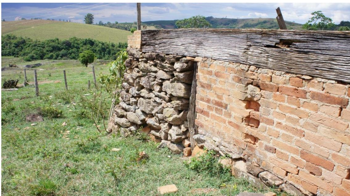
Figura 31: Foto dos alicerces da antiga casa do administrador da fazenda Barreiro. Vemos em detalhe o uso misto de materiais para sua estrutura.
