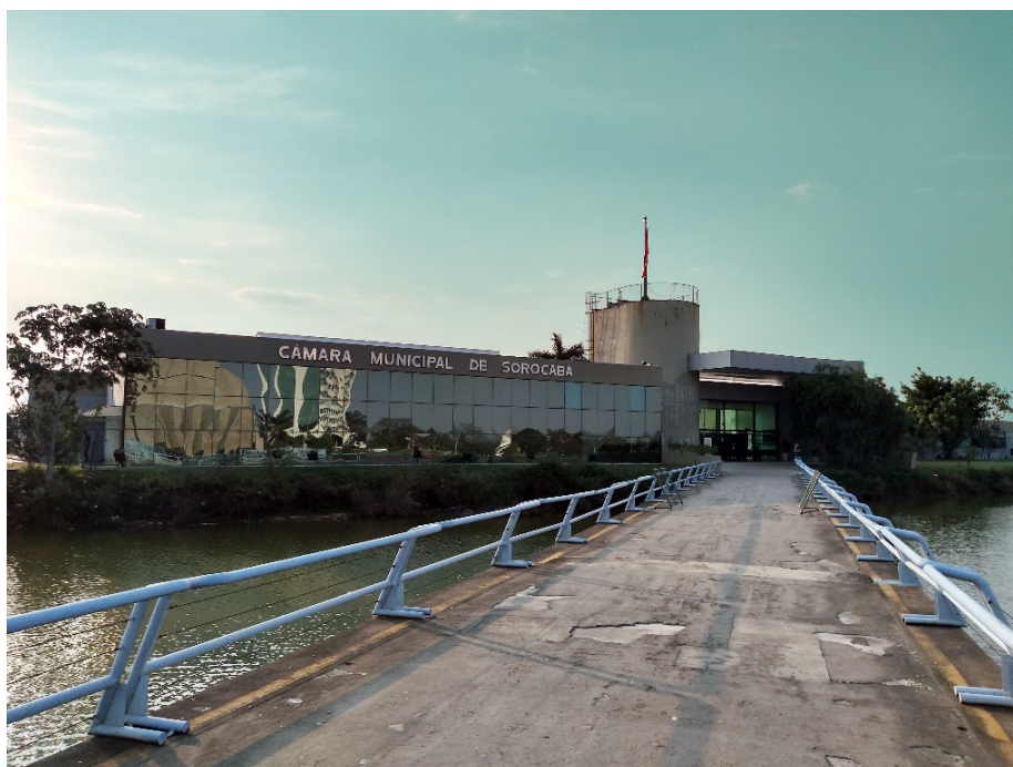
Figura 65 – Edifício da Câmara Municipal de Sorocaba Foto: autor, 2019
