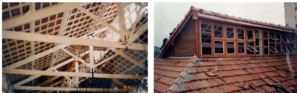
Figura 43 – Obras de restauro dos remanescentes Fonte: Relatório de conclusão do restauro, PA 5.131/1998 da SECULT
