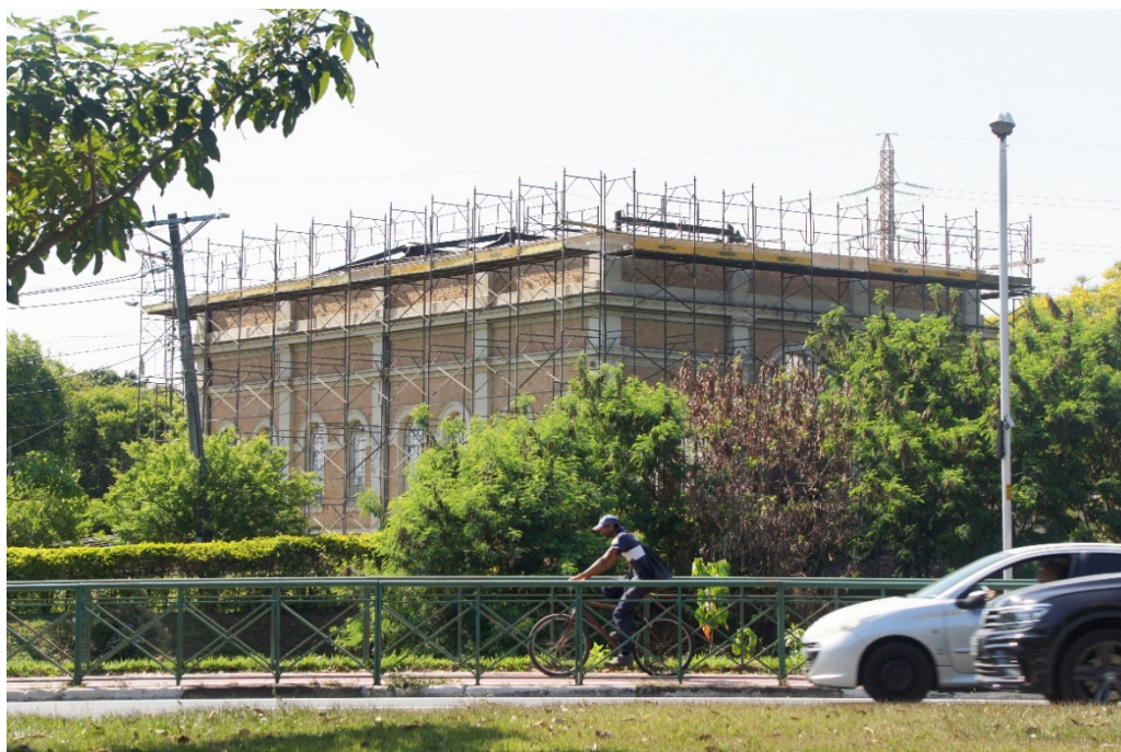
Figura 35 – Obra de restauro na antiga usina a diesel de 1909 Foto: autor, 2019
