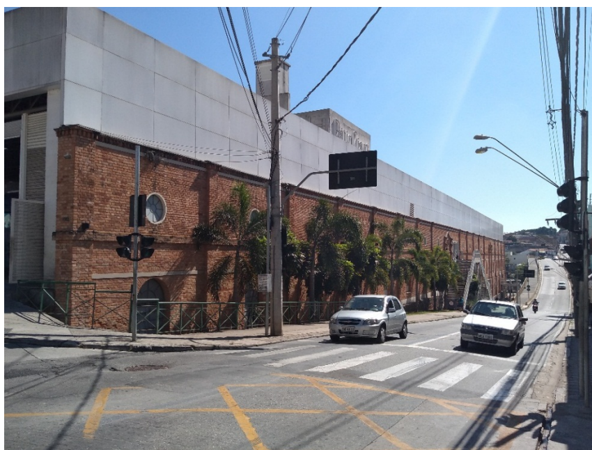
Figura 34 – Parede reconstruída do Pátio Cianê Shopping Foto: autor, 2019
