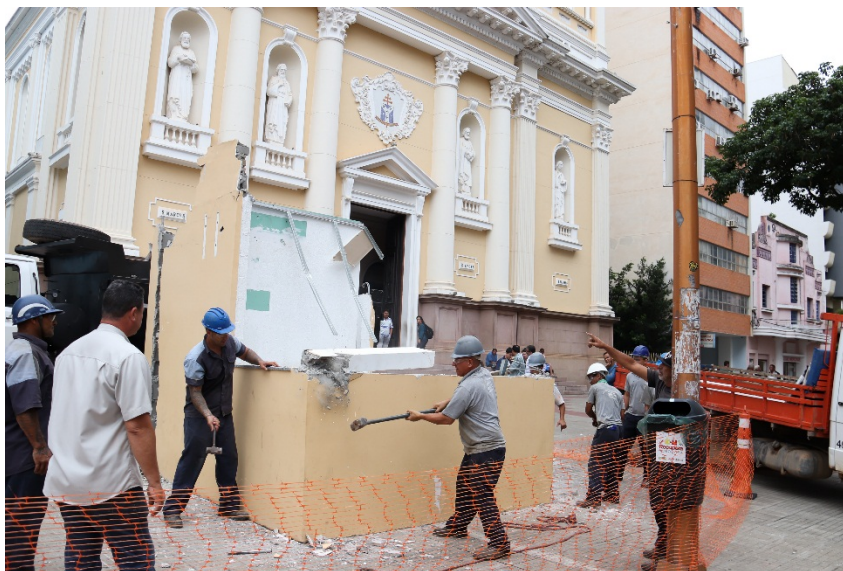
Figura 80 – Demolição da guarita da GCM
