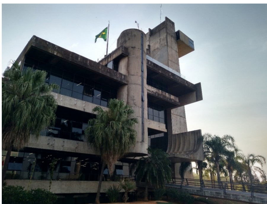
Figura 67 – Fachada do Paço aguardando a recolocação dos brises Foto: autor, 2019
