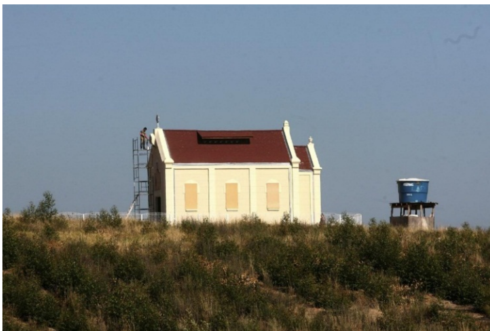
Figura 60 – Capela em fase final de restauro
