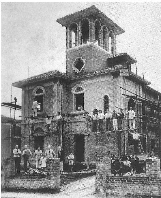
Figura 50 – Foto do Mirante Ondina em construção
