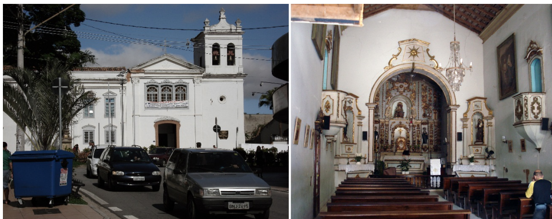
Figura 87 – Mosteiro e interior da Igreja de Sant’Ana antes do restauro Foto: autor, 2006
