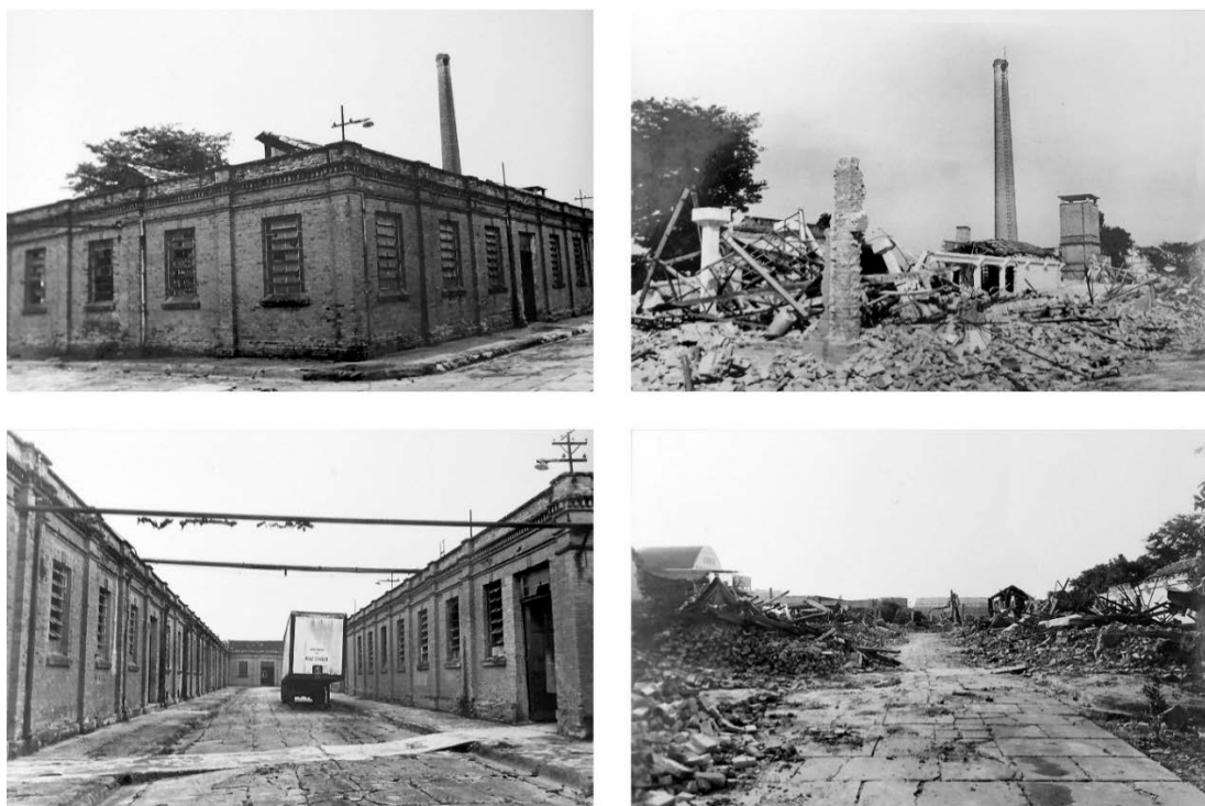
Figura 41 – Fotos antes e depois da demolição
