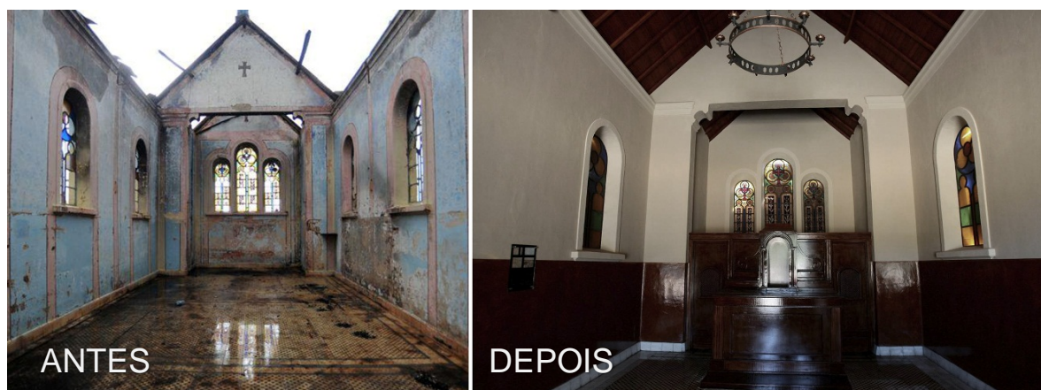
Figura 61 – Interior da Capela antes e depois do restauro
