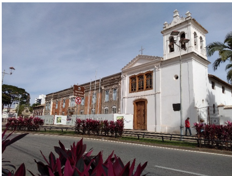
Figura 88 – Mosteiro de São Bento com a fachada parcialmente restaurada Foto: autor, 2019
