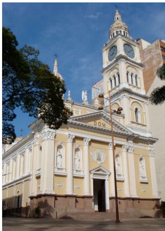
Figura 76 – Fachada da Catedral um ano após o tombamento Foto: autor, 2008
