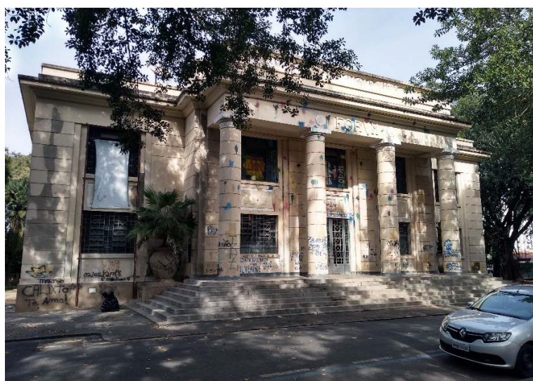
Figura 85 – Antigo Fórum Velho aguardando obras de restauro Foto: autor, 2019
