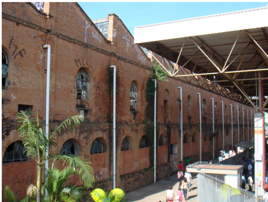
Figura 22 – Fábrica Santo Antônio Foto: autor, 2009
