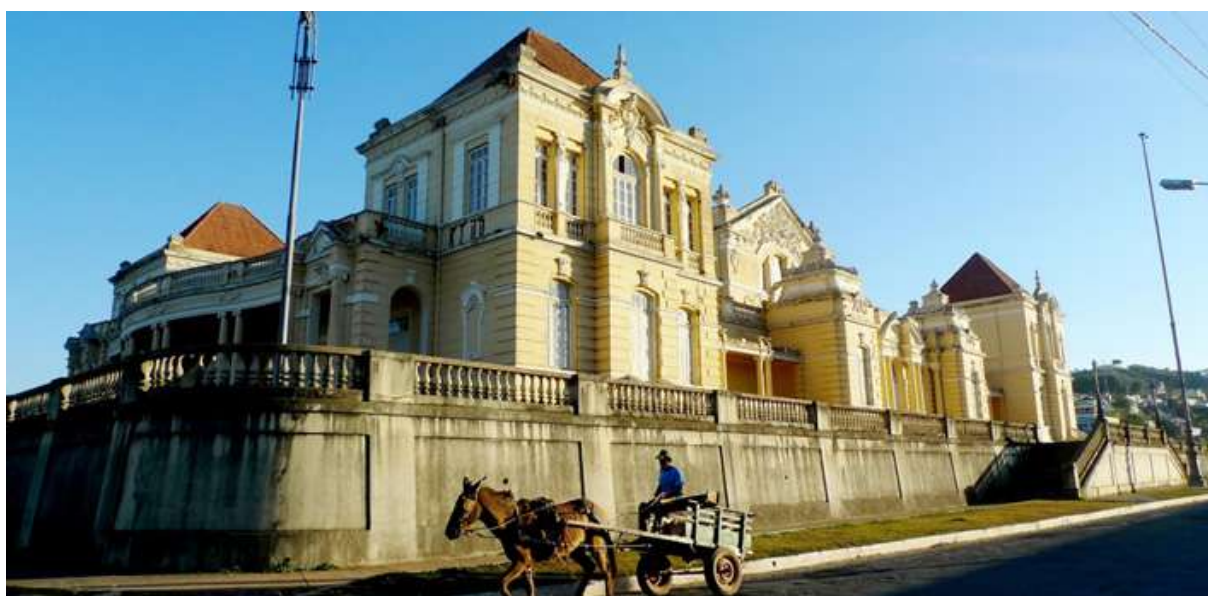
Figura 41 – O Edifício do antigo Cassino em Lambari. Fonte: Site do Instituto Estadual de Patrimônio Histórico e Artístico de Minas Gerais (IEPHA-MG). Disponível em: < https://cutt.ly/BjvfWuH > Acesso em 30.12.2020
