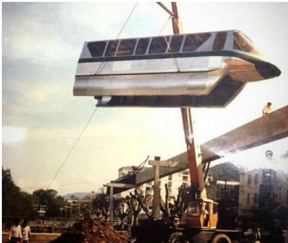
Figura 18 - Carro do monotrilho sendo colocado sobre os trilhos, por volta dos anos 1990. Fonte: CEOMFerreira. Disponível em < https://i.pinimg.com/564x/cb/fa/70/cbfa70908dee38a8e6e78141d8790843.jpg >. Acesso em 28.10.2020
