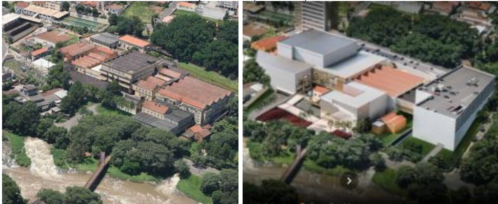
Figura 36 Comparação entre a Fábrica Boyes (à esquerda) e o projeto do Mirante Shopping aprovado (à direita).
