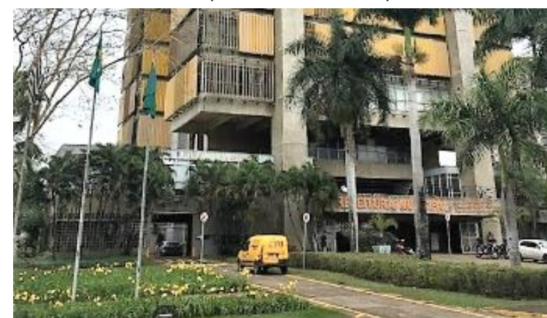
Figura 25 Prefeitura Municipal de Piracicaba (SP): espaço edificado, público e sem esfera pública.
