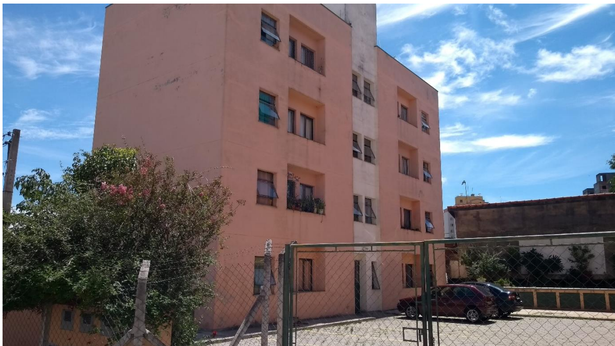
Figura 54 – Foto Vila Ana Bloco 3.
