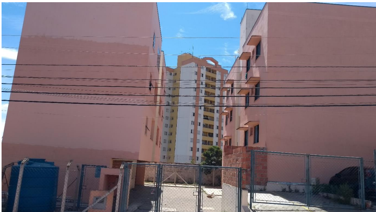
Figura 55 – Foto Vila Ana Bloco 5.
