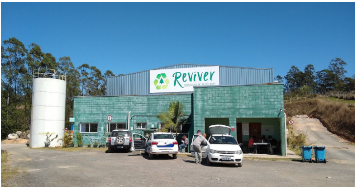
Figura 05. Vista do galpão de triagem de materiais recicláveis
