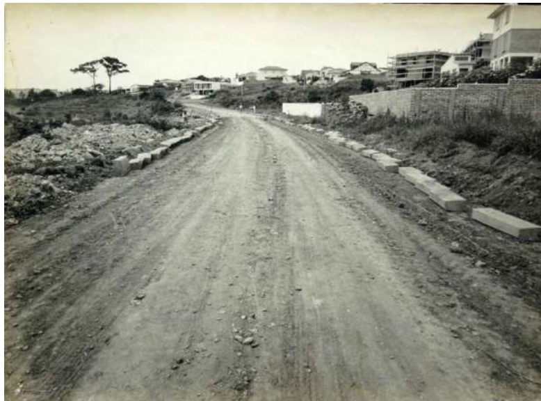
Figura 94: Rua sem pavimentação com distribuição de material para começar o recapeamento s/id
