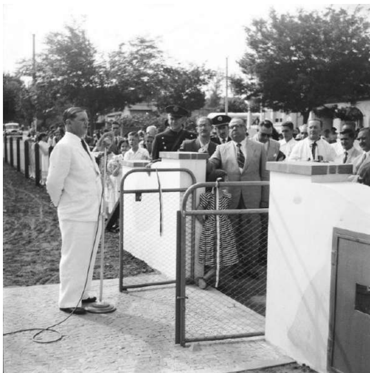
Figura 102: Administração Lauro Péricles Gonçalves obras s/id
