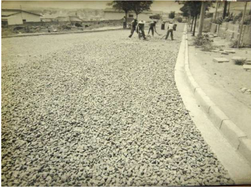
Figura 95: Operários trabalhando no recapeamento [talvez da mesma] rua s/id.
