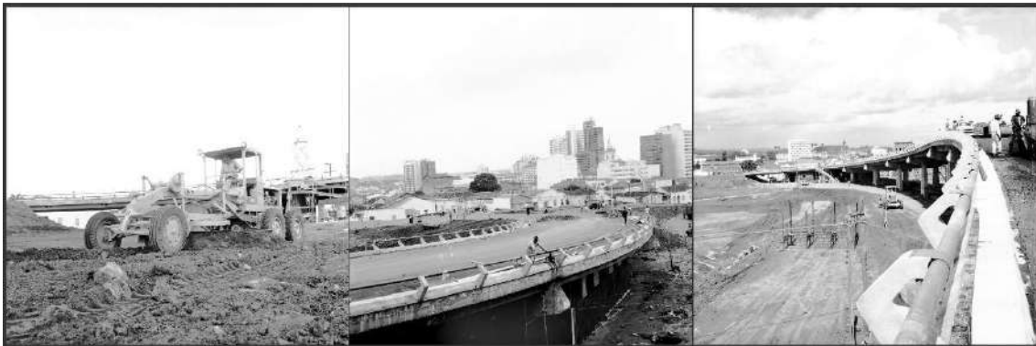
Figura 70: Construção do viaduto Miguel Vicente Cury
