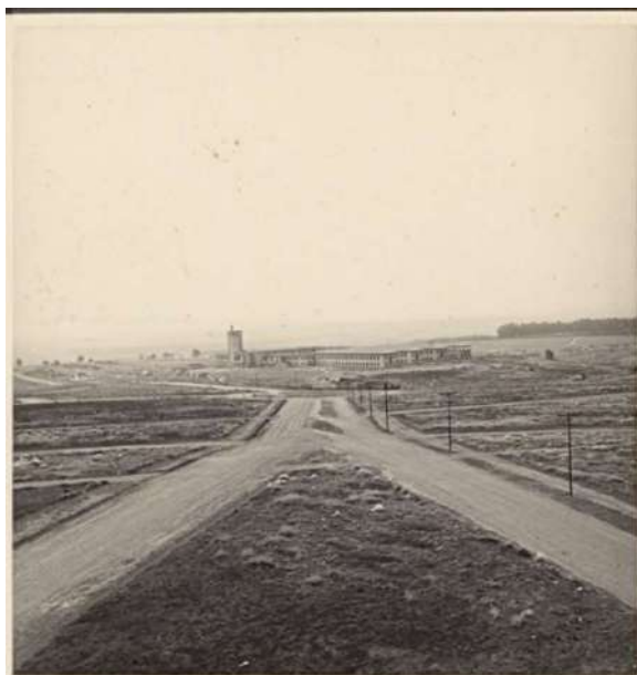
Figura 92: Construção da escola preparatória de cadetes do Exército
