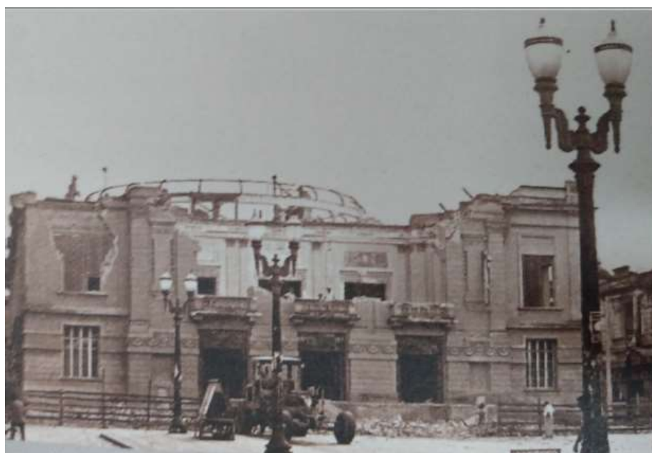
Figura 69: Demolição do teatro municipal de Campinas, 1965
