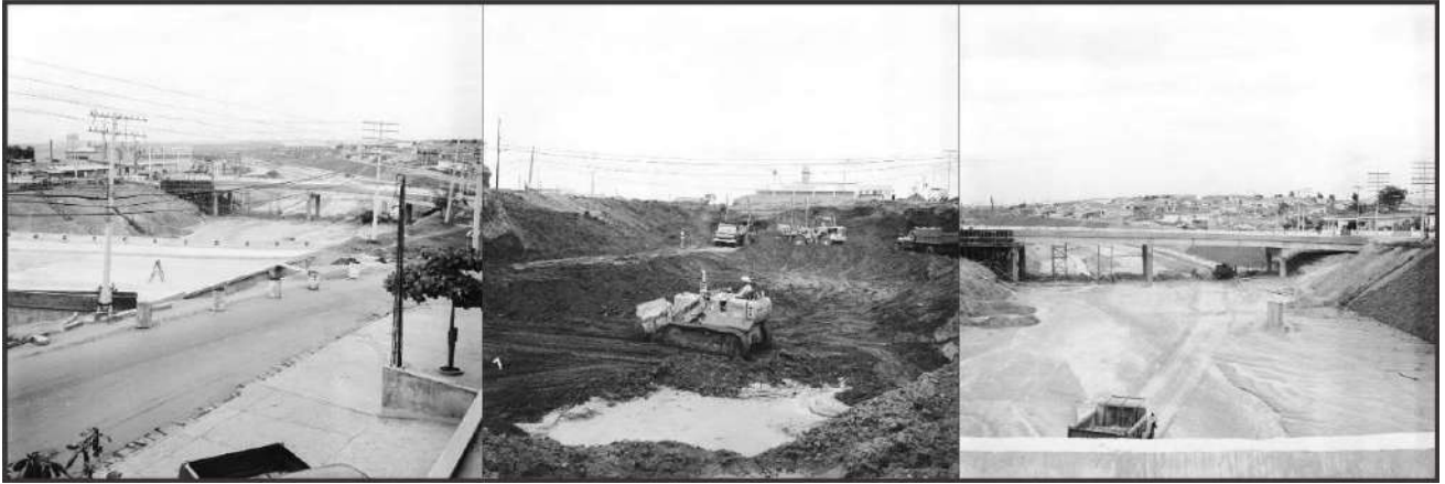
Figura 93: Construção do jardim do trevo no bairro São Bernardo com a rodovia Anhanguera Fonte: Acervo do Museu de Imagem e Som, Autor: Henrique Oliveira Jr. Data 1951.
