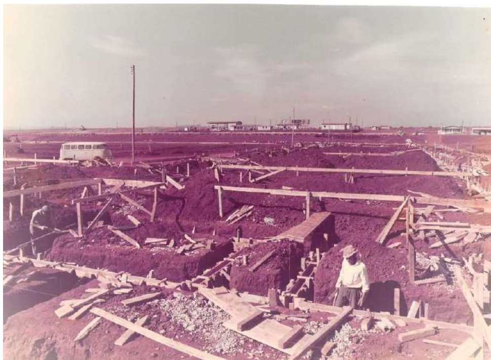
Figura 90: Construção da instituição pública CEASA
