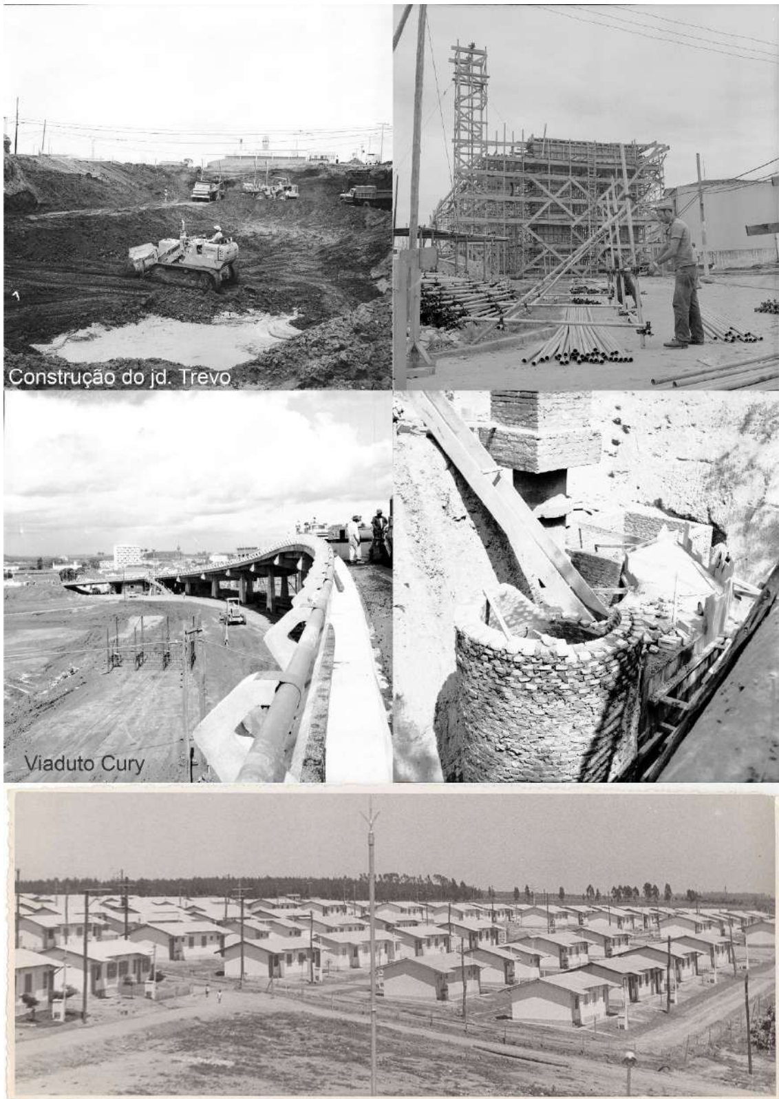
Figura 108: Conjunto de fotografias com registros da implementação de infraestruturas em andamento, em diversos pontos da cidade
