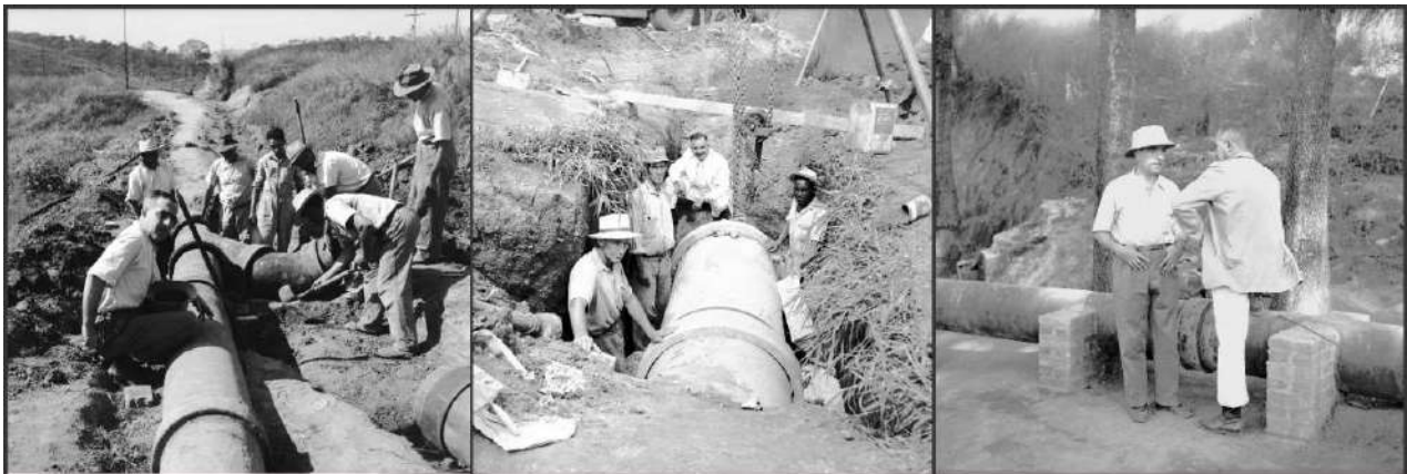
Figura 98: Registro do Engenheiro Alfredo Sizenando Ribeiro fiscalizando o andamento da obra. (fotos da direita para a esquerda) - o engenheiro Alfredo S. R. está apoiando o pé na tubulação; no registro fotográfico ao centro o engenheiro Alfredo S. R. se encontra agachado ao centro; na fotografia esquerda o engenheiro Alfredo S. R. aparece de costas.
