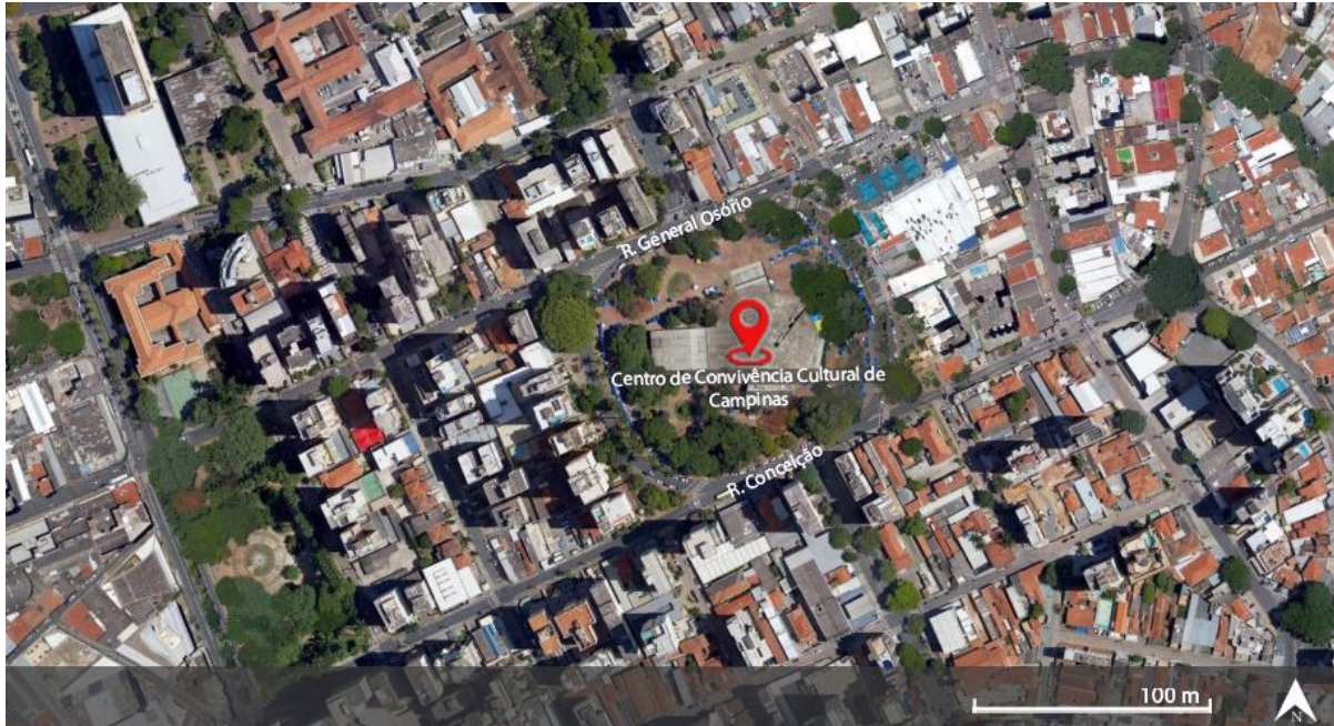
Figura 19: Foto aérea do Centro de Convivência Cultural de Campinas. Fonte: Elaboração própria a partir de Google Earth, 2021.
