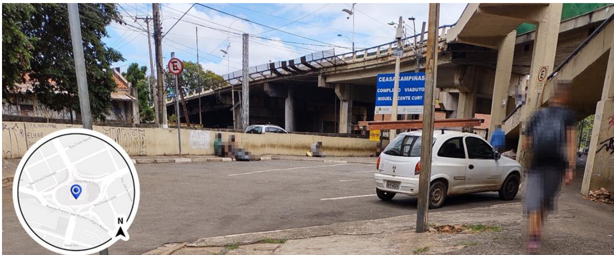
Figura 39: Rua de acesso à Av. Doutor Moraes Salles, população em situação de rua e transeuntes. Data: 11/10/21. Horário: 11:51h. Local: Baixos do Viaduto Miguel Vicente Cury. Fonte: Autora, 2021. Fonte do Mapa: Elaboração própria a partir de MAPBOX, 2021.
