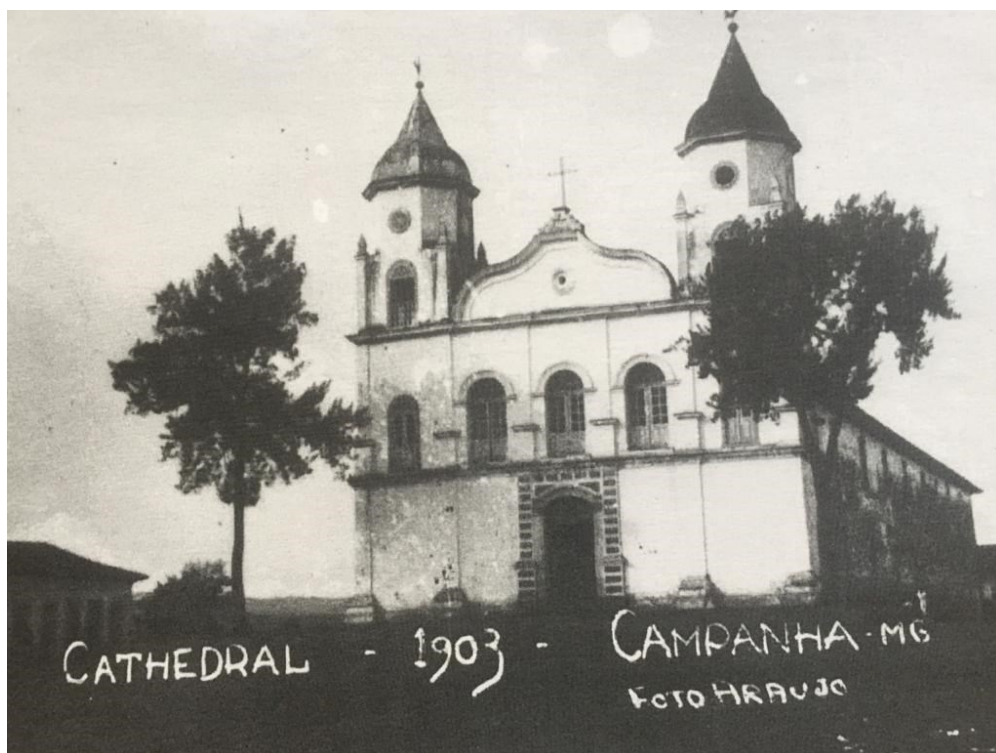
Figura 72. Campanha, fachada da Igreja Matriz, depois Catedral. Foto Araújo, 1903. Construída em taipa-de-pilão, a partir de 1787, a igreja teve duas torres construídas bem mais tarde, no final do século XIX. Notar a portada frontal, em pedra entalhada, com arco pombalino, provavelmente entalhado pelo mestre Francisco de Lima Cerqueira. Fonte: Centro de Estudos Campanhenses Monsenhor Lefort
