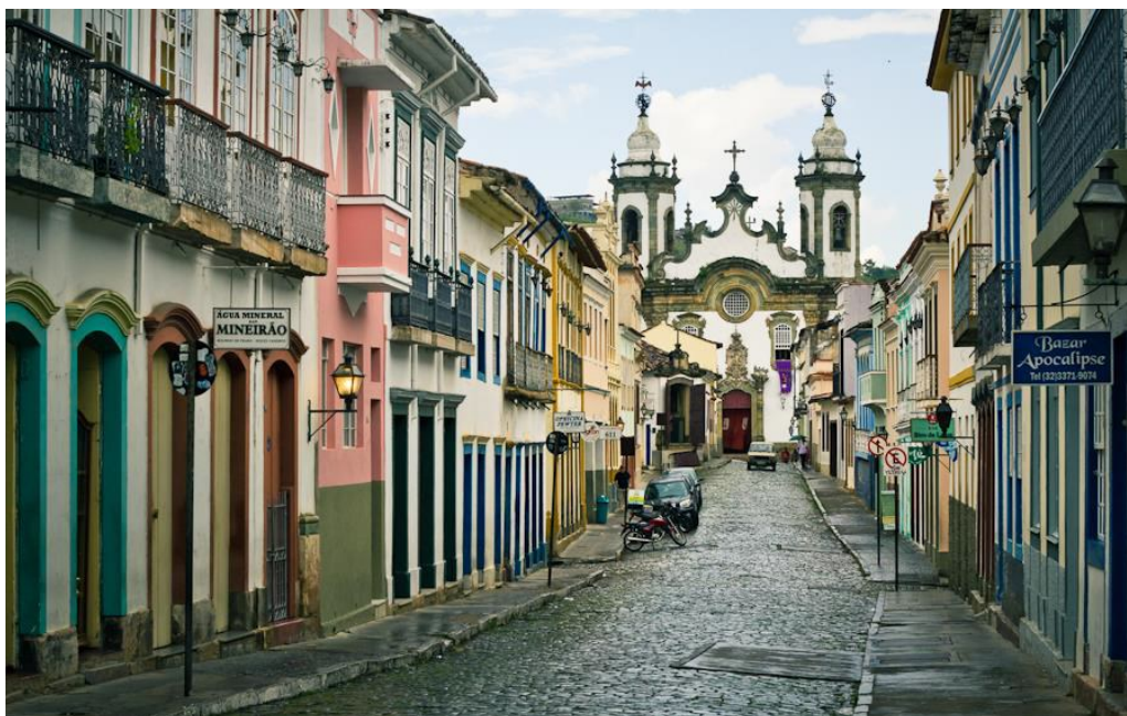
Figura 62. São João del-Rei, Rua Getúlio Vargas, antiga Rua Direita, anos 2000. Partindo da fachada da Capela da Ordem Terceira do Carmo, esta rua varia em suas larguras até a fachada da Capela de Nossa Senhora do Rosário. Através das capelas dos Passos, dá passagens às encenações da Semana Santa. Fonte: https://i.pinimg.com/originals/3c/59/62/3c59622bbe0e11b70ab84e5117zead45.jpg
