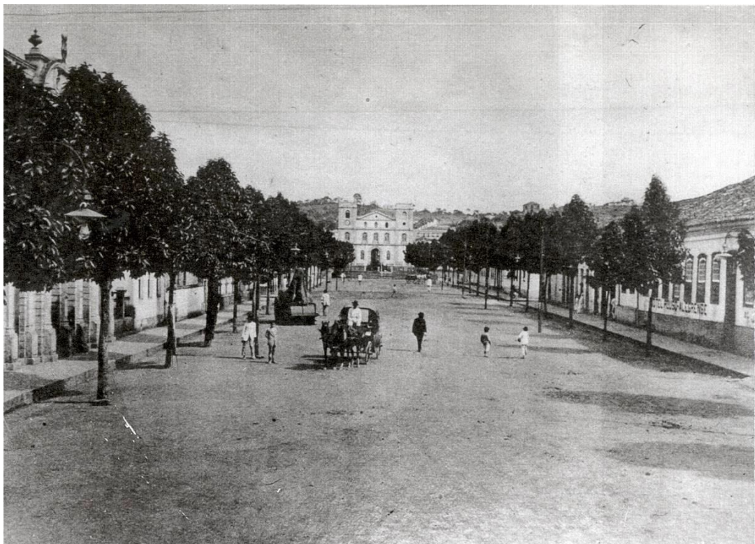
Figura 94. Pouso Alegre, Largo da Matriz, atual Avenida Dr. Lisboa, início do século XX. Os postes de iluminação e a arborização, fora das calçadas, induziriam o seu prolongamento. Fonte: Museu Histórico Municipal Tuany Toledo
