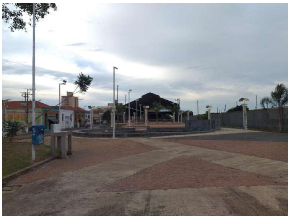
Figura 60. Vista da Praça dos Ferroviários, depois da intervenção de revitalização, indicando o Teatro de Arena e ao fundo a Estação Ferroviária.
