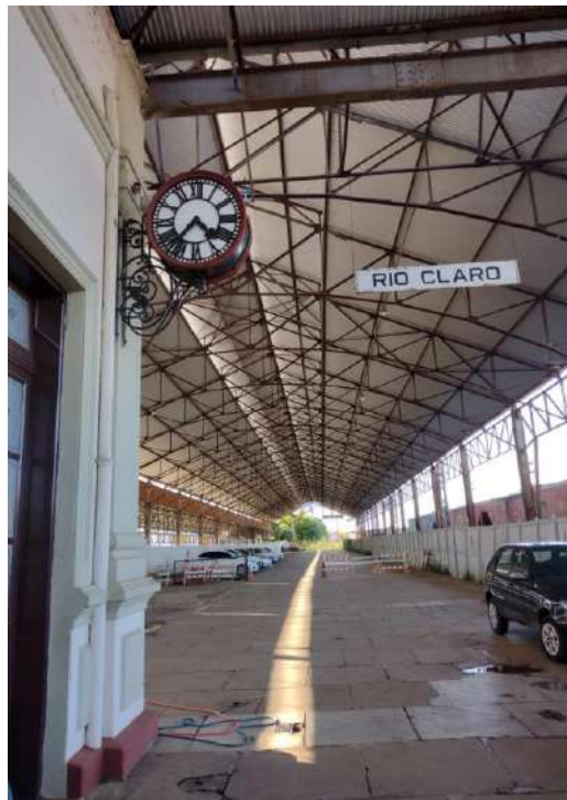
Figura 71. Imagem da Sala do Relógio da Estação Ferroviária.
