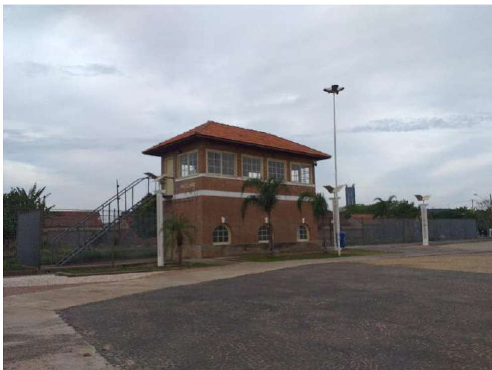
Figura 59. Vista da cabine de chaves da Avenida 7, bairro Centro.
