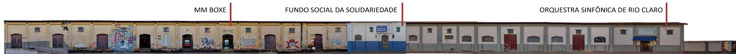
VISTA 1 - GALPÃO CULTURAL (ANTIGO BARRACÃO C.P.E.F.) RUA1B, ENTRE AV. 4A E 1A - BAIRRO CIDADE NOVA
