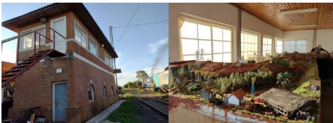
Figura 72. Imagens da Cabina de Chaves da Av. 8, ocupada como centro de ferromodelismo.
