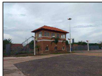
2) Imagens da Cabine de Chaves da Av 7 e gradil
