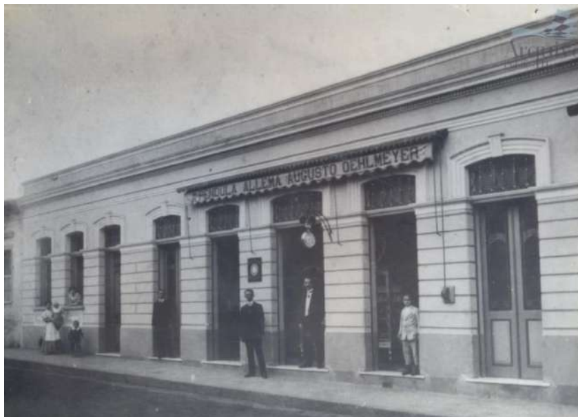
Figura 02. Imagem da Fachada da “Pêndula Alemã ‘Augusto Oehlmeier’”, antigamente localizada na Rua 5, entre as Avenidas 4 e 6. Sem data definida.
