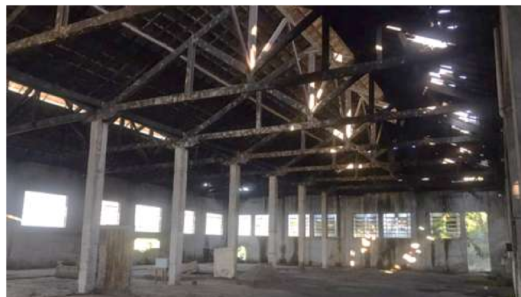
Interior galpão (atualmente)
