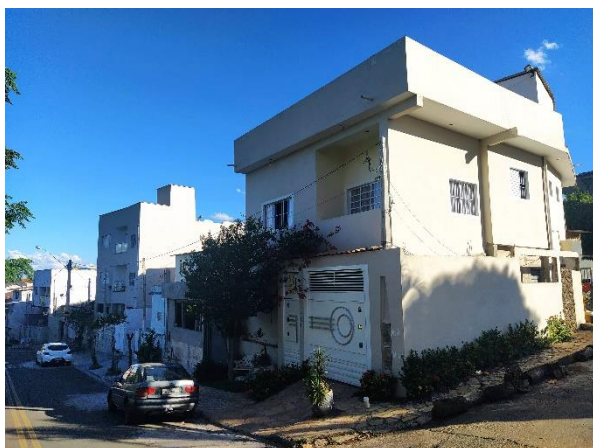
Figura 36. Edificação na Rua Suzeley Norma Bove
