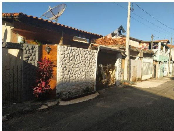
Figura 37. Edificação no Caminho 9
