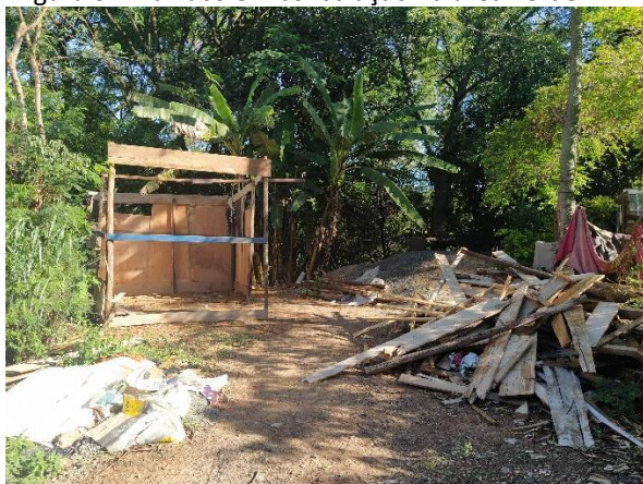
Figura 31. Barraco em construção na área verde
