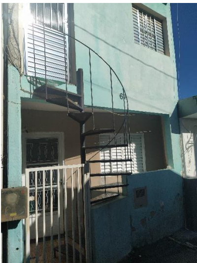
Figura 33. Casa revestida com pintura
