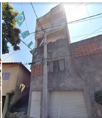
Figura 48. Casa de 4 pavimentos, com acessos pelo caminho e pela viela lateral
