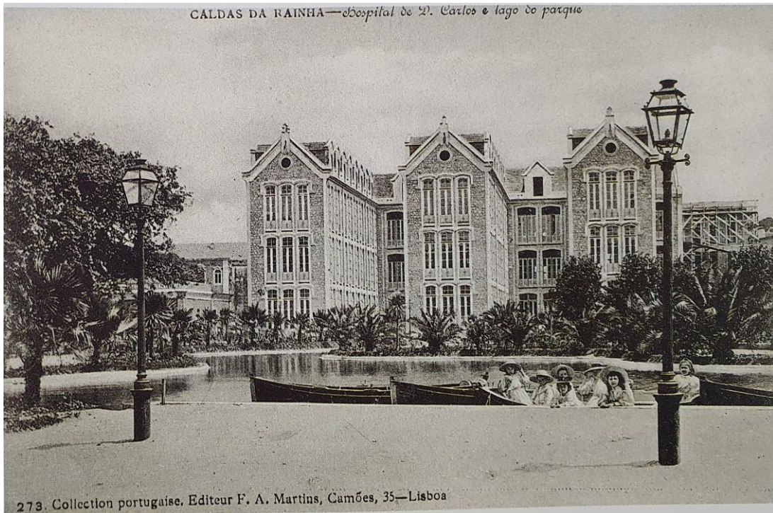
Figura 95: O novo Hospital de Caldas da Rainha, cerca de 1897, com os pavilhões em fase de acabamento. Fonte: (TRANCOSO, 1999, figura 140)
